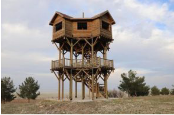
Resim. 6 Kuş gözlem kulesi
