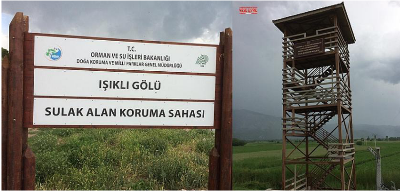
Resim 1. Kuş gözlem kulesi
