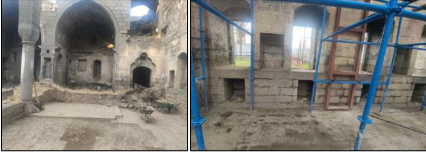
Şekil 15. Temizlik Sonrası Döşeme ve Niş Bulguları
