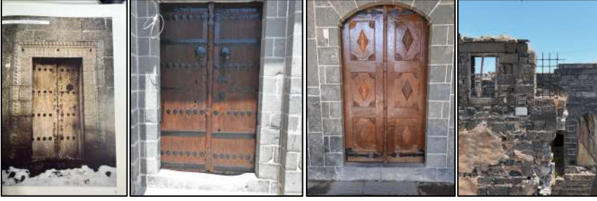
Şekil 21. Yapı Elemanları Arşiv Fotoğrafı (Tuncer, 2002), Kapı Örnekleri (2,3) ve Mevcut Lokma Demir Korkuluk
