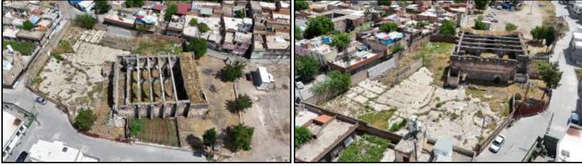
Şekil 2. Kilise Yapısı Dron Fotoğrafı-2025
