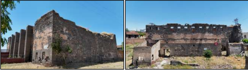
Şekil 4. Güneydoğu ve Batı Cephesi
