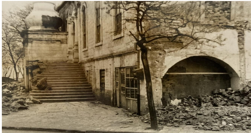
Görsel 5. Yalı Camii'nin çevre düzenlemesi öncesinde, mevcut olan büfe, kahvehane ve ilave binaların görünümü (Tarih bilinmiyor) (Hüseyin Naim Güney Arşivi)
