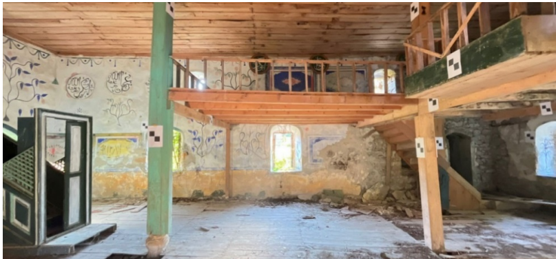
Görsel 19. Batı Duvarı Üzerindeki Süslemelerin Genel Görünümü
