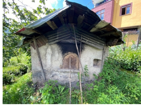
Görsel 43. Fırın Batı Cephesi
