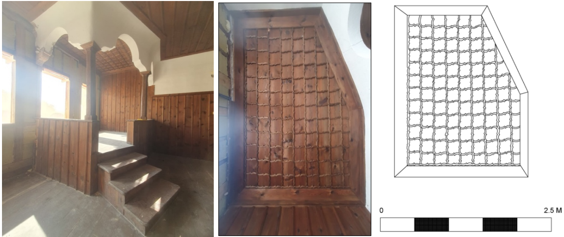
Görsel 3-4-5. Köşk Bölümü Genel Fotoğrafı, Köşk tavanı ve çizimi (Çizim, SELŞAH Mimarlık, Mimar Selim ŞAHİN)
