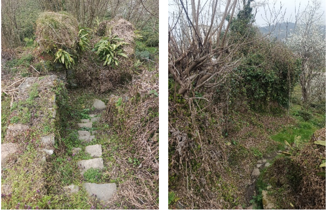
Görsel 2-3. Konağa uzanan yol ve zemin kat duvar kalıntıları (Derya Topaloğlu, 2025)
