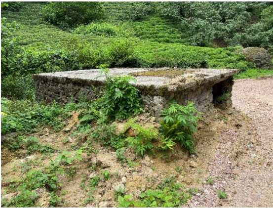
Görsel 17. Değirmen Kuzey ve Doğu Cephesi
