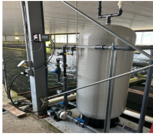
Şekil 2. Kapalı devre Yetiştiricilik sistemlerinde Ozon jeneratörü (URL-1, 2025)
