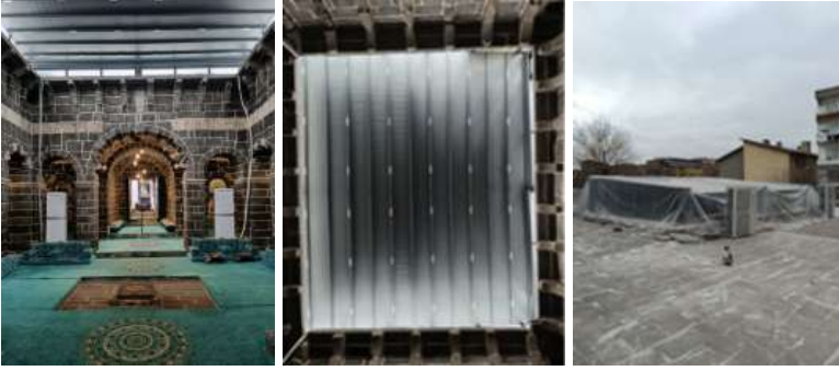
Şekil 8. Medrese avlusunun metal ve cam elemanlarla kapatılması (2026)
