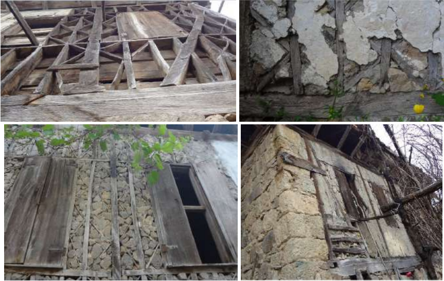
Şekil 10. Güneyce Mahallesi Ahşap, Taş, Kireç ve Kil Malzeme Kullanımı (Tarım, 2025)
