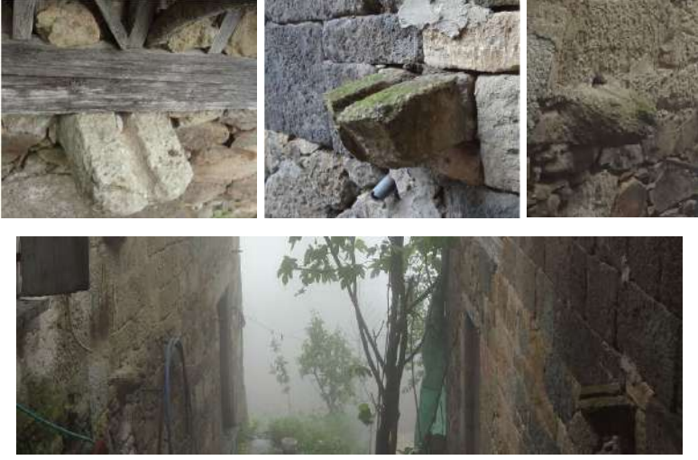
Şekil 28. Güneyce Mahallesi Yöresel Konutlarında Çörten Kullanımı (Tarım, 2025)
