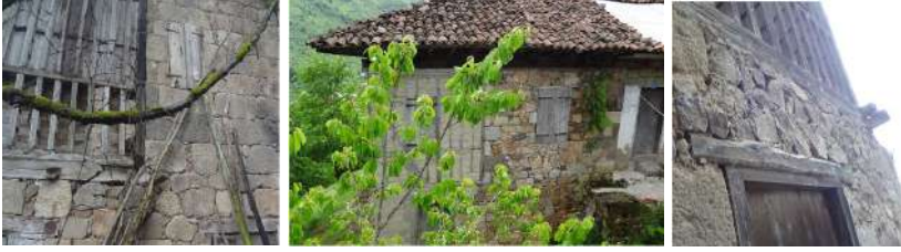
Şekil 12. Güneyce Mahallesi Kagir Duvar Sistemi (Tarım, 2025)
