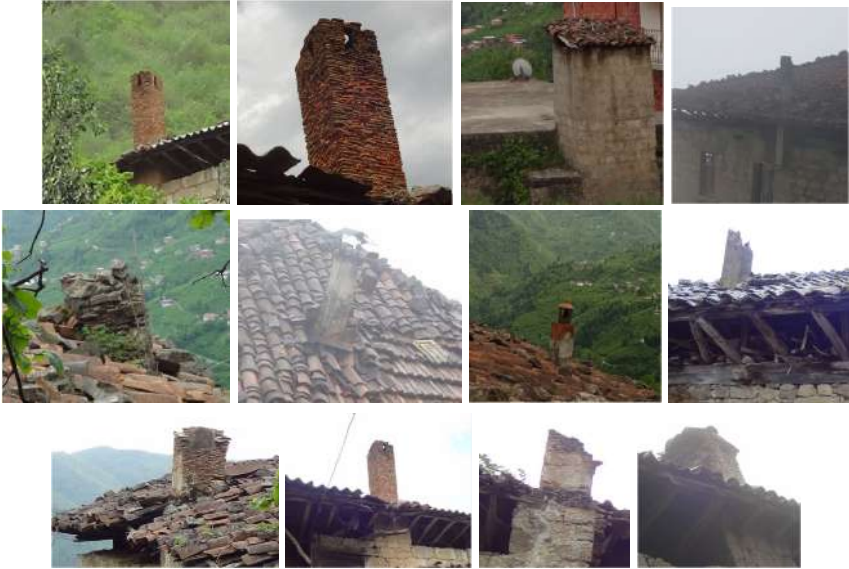
Şekil 27. Güneyce Mahallesi Yöresel Konutlarında Baca Kullanımı (Tarım, 2025)
