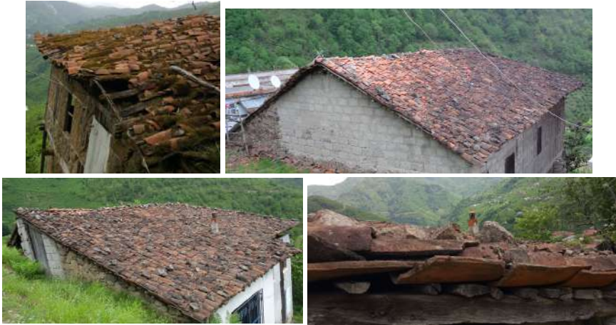
Şekil 18. Güneyce Mahallesi Yöresel Konutlarında Kiremit Kullanımı ve Semer Tip Çatılı Evler (Tarım, 2025)
