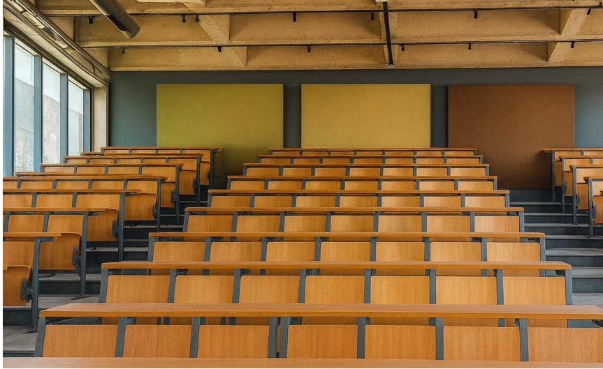
Şekil 10. Dersliğin arka duvarında uygulanan akustik iyileştirme senaryosu görseli
