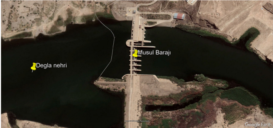
Şekil 6: Musul barajı ve hidroelektrik santrali (Degla / Dicle) (Google Earth 2022)
