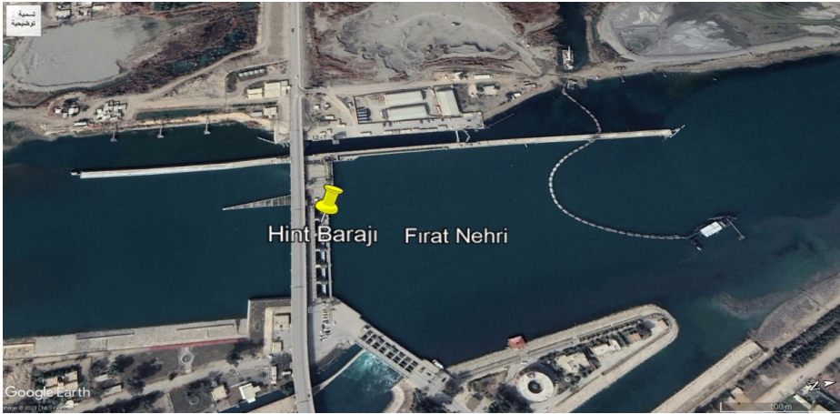
Şekil 7: Al-Hindiya / Hint barajı ve hidroelektrik santrali (Google Earth 2022)
