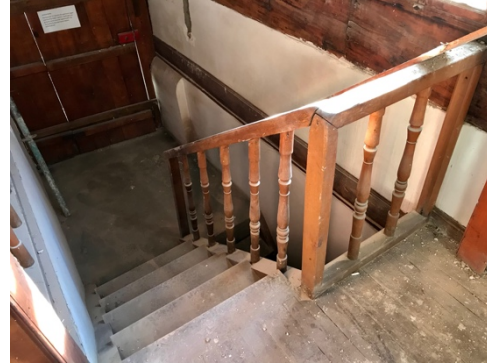
b) Zemin kat ile birinci kat arasındaki merdiven.
